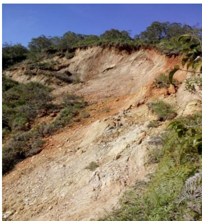
Deslizamiento de tierra generado por la ruptura de la tubería de aguas negras en la aldea Piedras Blancas, Zona Metropolitana. Foto Lina Sarmiento, 2019.
